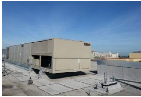
65 Ton McQuay AC Unit
